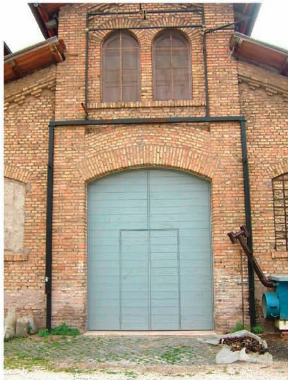
Sala B: ingresso materiali
